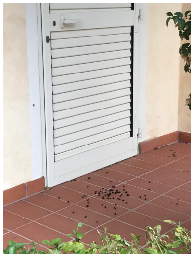
escrementi intorno alle abitazioni
